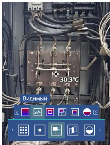
**Выделение контуров:** инфракрасный снимок с выделением всех контуров.
